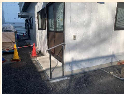
外部階段手摺新設・集会室手摺新設（助成金利用）
