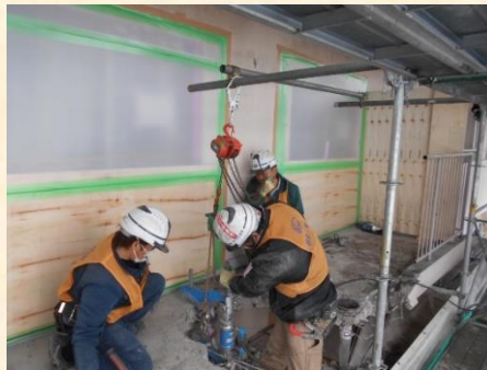
油圧式ハンドクラッシャーでの解体状況
