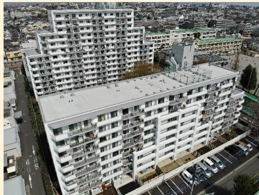
施工後 ドローンによる撮影
