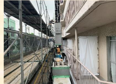
PC 吊り込み状況
