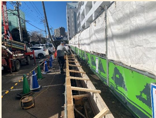
ブロック塀基礎部の補強工事の様子
