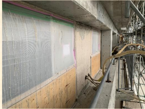
プラベニヤによる採光可能な窓ガラス養生
