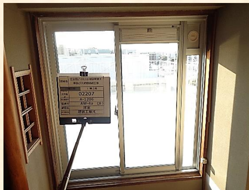
配管が通せる特注サッシへの交換工事
