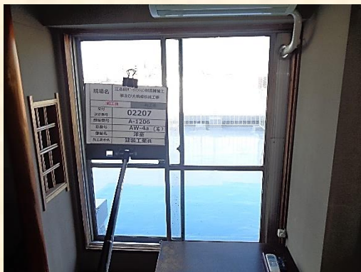
配管が通せる特注サッシへの交換工事
