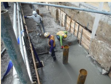
基礎工事状況
