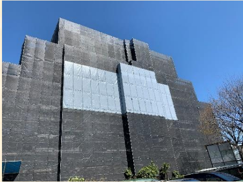
採光防音シートの設置状況
