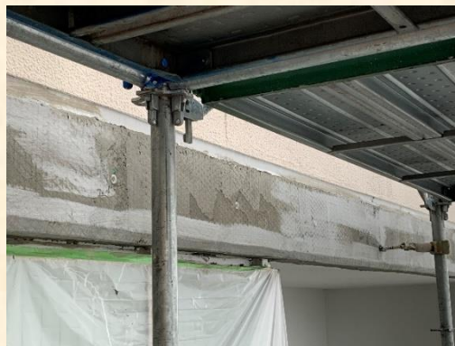
ピンネット工法による補修工事状況
