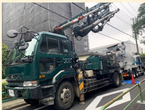
工事中に出入りした大型車両（一例）
